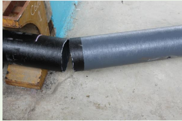
شکل ۹. تخریب پایه چدنی
