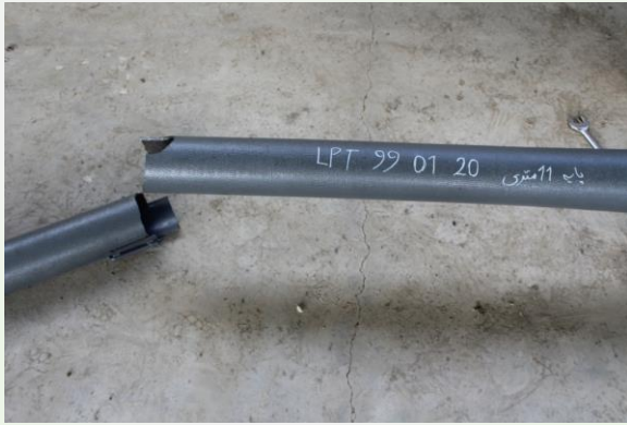
شکل ۱۰. تخریب پایه چدنی
