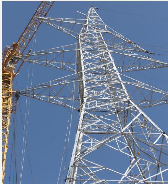
شکل ۶. تغییر شکل دکل G30-2T پس از آزمون تخریب
