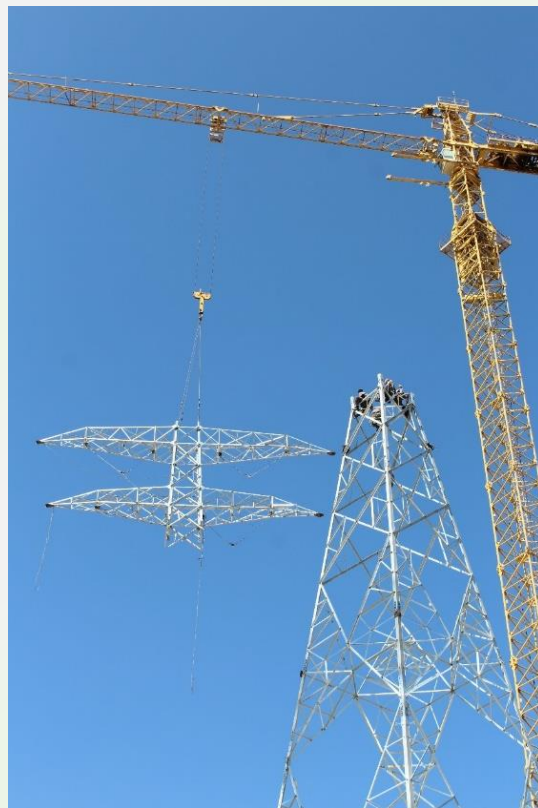
شکل ۲. نمونه‌ای از نحوه مونتاژ عمودی دکل KZS4-3
