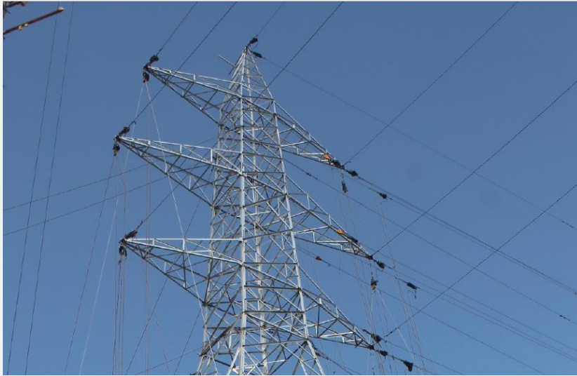
شکل ۵. نمونه‌ای از نحوه سیم‌کشی بر روی دکل G30-2T
